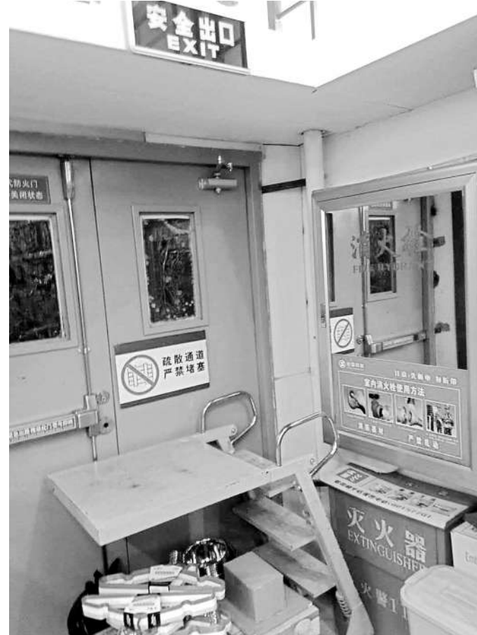
超市里的货品被堆放在消防栓前,且旁边就是安全出口。一旦发生火灾,将影响人员逃生及取用消防器材。
